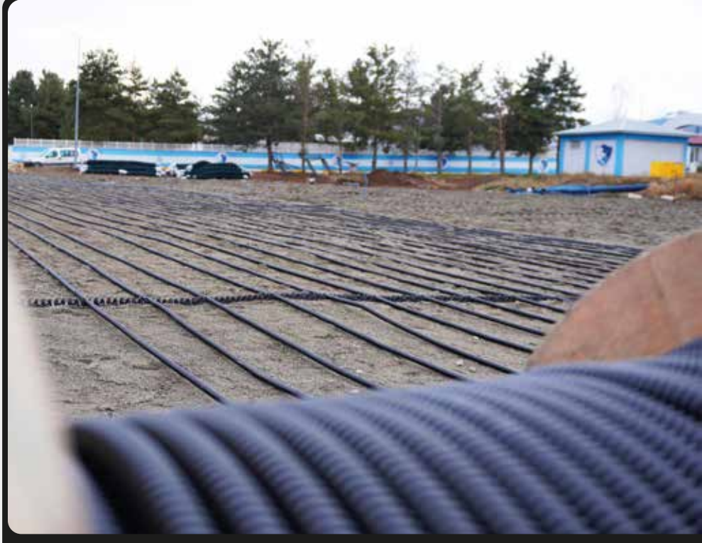
Yakutiye / Erzurum floorflex Montajı
