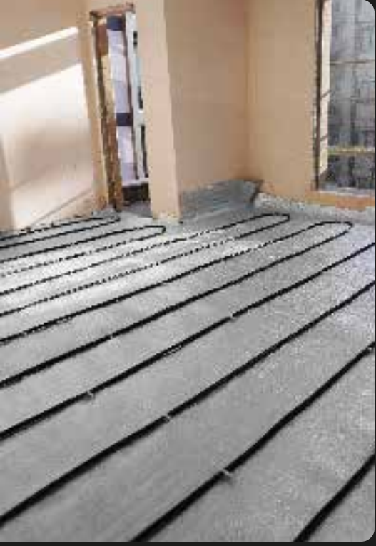
Cevizli / İstanbul | Şilte Uygulamalı floorflex Montajı
