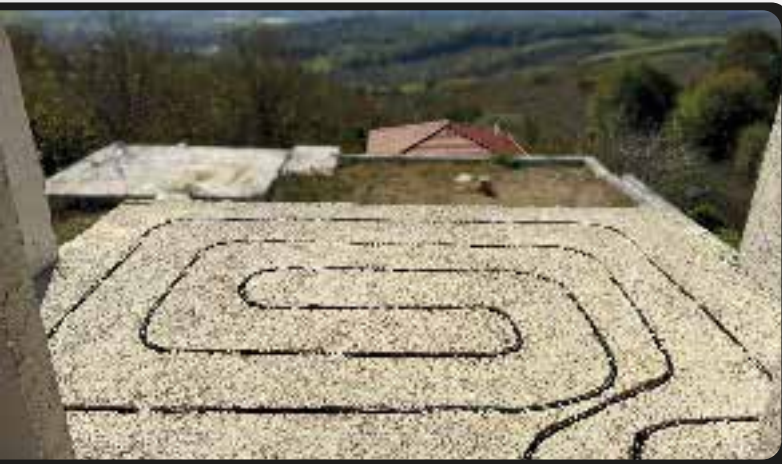
Ağacık / Sakarya | Şapkes Uygulamalı floorflex Montajı
