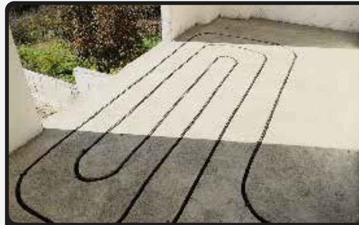
Ağacık / Sakarya | Şapkes Uygulamalı floorflex Montajı
